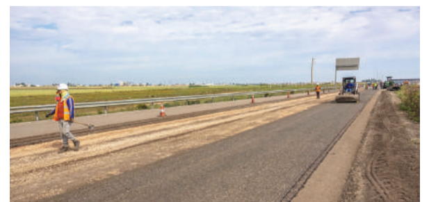
| Travaux de grosses réparations de l'autoroute Casablanca-Settat
