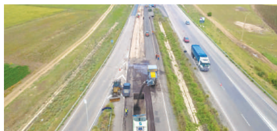
| Vue aérienne des Travaux de grosses réparations de l'autoroute Casablanca-Settat
