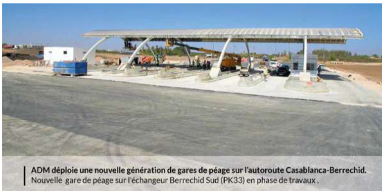
ADM déploie une nouvelle génération de gares de péage sur l'autoroute Casablanca-Berrechid. Nouvelle gare de péage sur l'échangeur Berrechid Nord (PK21) en phase de travaux - Auvent métallique à conception architecturale innovante.
