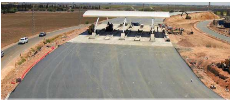
ADM déploie une nouvelle génération de gares de péage sur l'autoroute Casablanca-Berrechid. Nouvelle gare de péage sur l'échangeur Berrechid nord (PK21) en phase de travaux.
